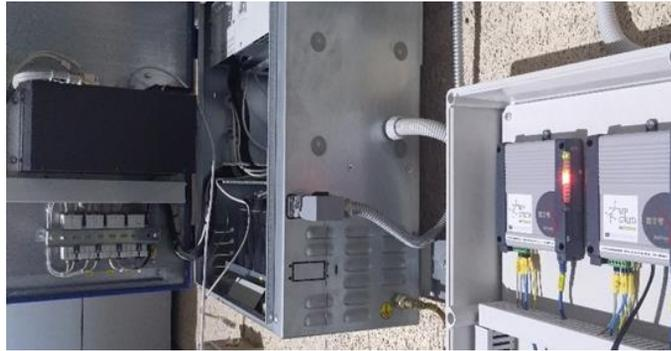
Figura 3. Instalación en campo del caso de uso 1. Equipos PRIME GTP (derecha) y RTU (al fondo).
