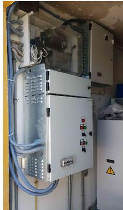
Armario control transformador
