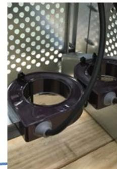
Toroidal Intensidad de Neutro por salida
