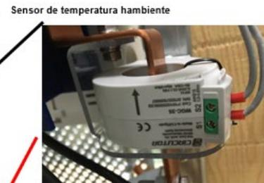
Toroidal Intensidad de Fuga a tierra
