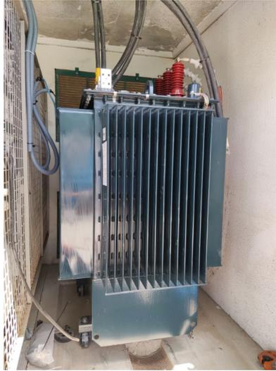
Transformador con regulación en carga
